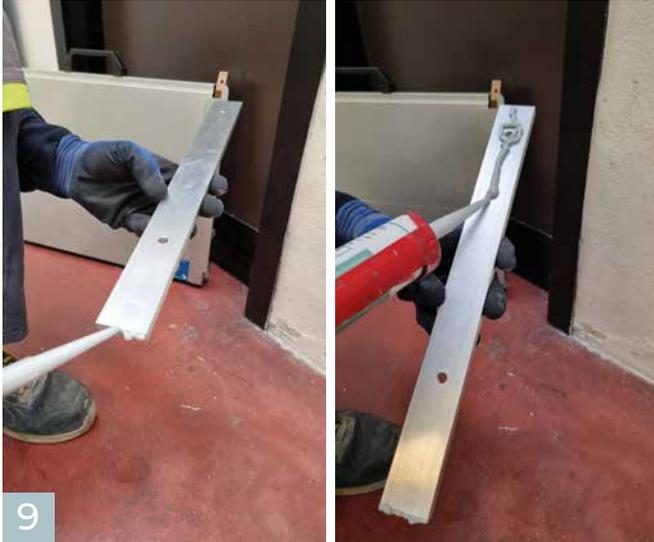
Tragen Sie Dichtstoff auf die Bodenaufschlagflächen der Distanzprofile sowie auf die Wandkontaktflächen auf.
