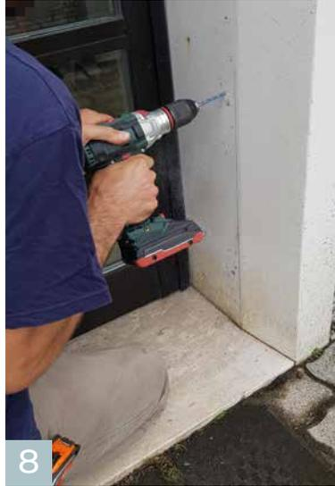
8 Bohren und die Dübel einsetzen.
