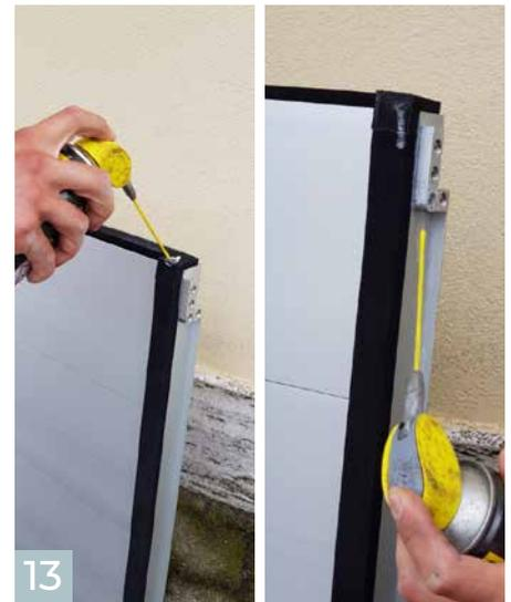
Schmieren Sie die Dichtungen und das Rückhaltesystem der Wasserschutz-Wand.
