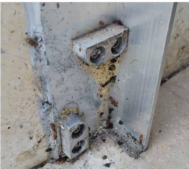
Die Montagewinkel müssen besonders im Bereich der Rückhalte- und Aufschwimmsicherungen von Schmutz freigehalten werden. Durch Verschleiß und Korrosion beschädigte Montagewinkel müssen ausgetauscht werden.
