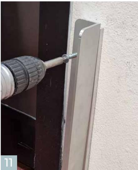
Setzen Sie Distanzprofil und Montagewinkel zuerst am Boden auf und befestigen Sie sie an der Wand. Bitte die Angaben des Dübelherstellers zum maximalen Drehmoment beachten!
