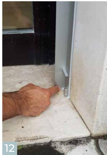
Überschüssigen Dichtstoff entfernen.
