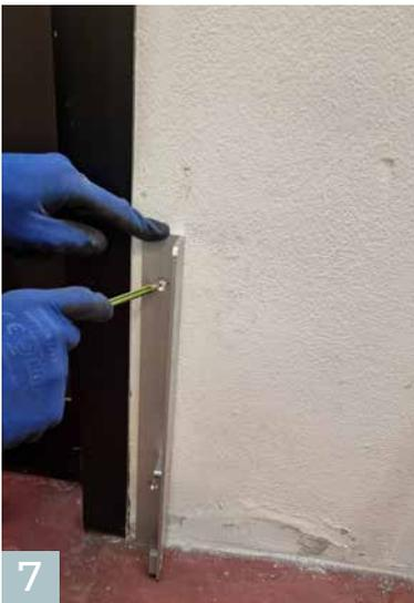
Die Position der Bohrlöcher an
