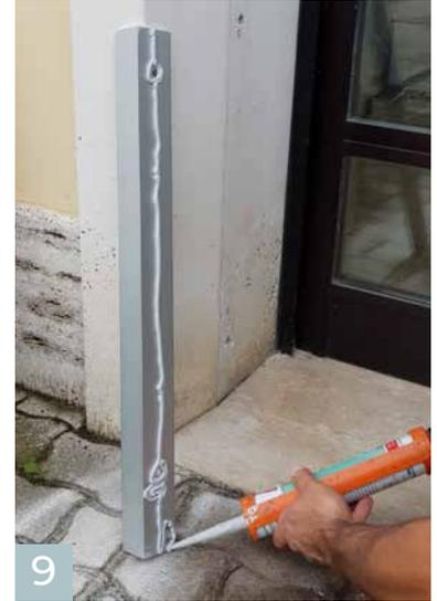
9 Auf der Wandseite des Montagewinkels und an der Rückseite der Nieten Dichtstoff auftragen.
