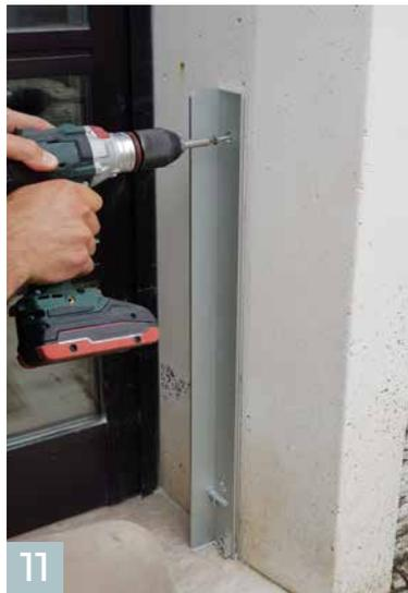
11 Setzen Sie die Montagewinkel zuerst am Boden auf und befestigen Sie ihn an der Wand. Bitte die Angaben des Dübelherstellers zum maximalen Drehmoment beachten!
