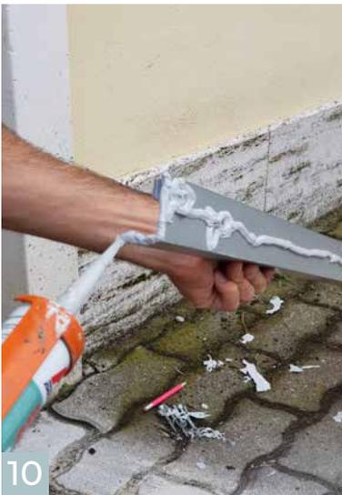
10 Auf die Bodenaufstandsfläche des Montagewinkels Dichtstoff auftragen.
