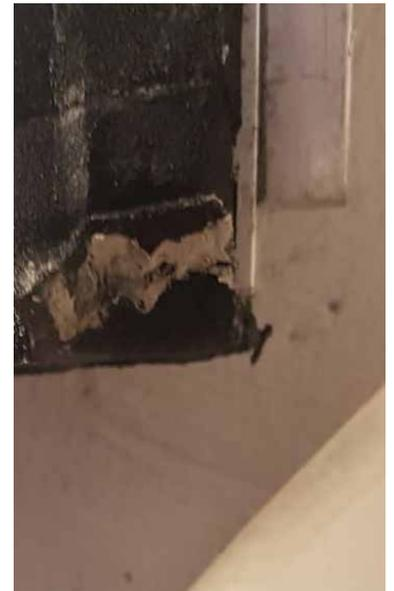
Beispiele für beschädigte Dichtungen, die die Funktion der Wasserschutz-Wand beeinträchtigen können.
