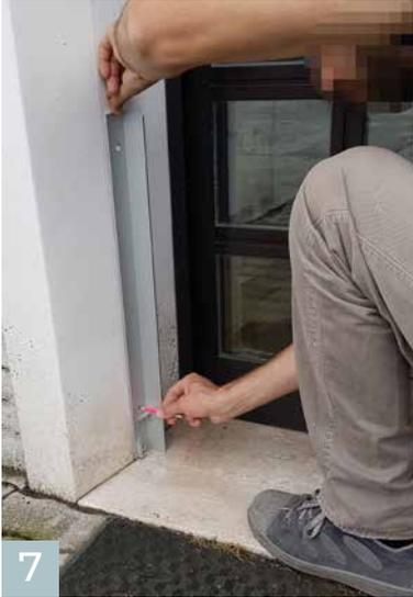
7 Die Position der Bohrlöcher an der Wand markieren.
