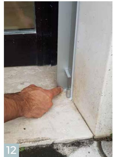
12 Überschüssigen Dichtstoff entfernen.
